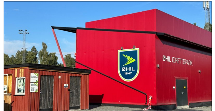
– Det er anlagt noen bygninger med stålplatekledning, som i all hovedsak er for å tilfredsstille interne bruksbehov, uten særlig hensyn til nabobebyggelse og/eller estetikk, skriver innsenderen. FOTO: PRIVAT
