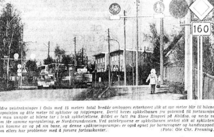
Eldre veistrekningen i Oslo med 15 meters total bredde ombuges etter hvert slik at syv meter blir til bilens disposisjon og åtte meter til syklister og fotgjengere. Dertil heves sykkelbanen fra gatenivå til fortaustnivå, og man unngår at bilene tar i bruk sykkelfeltene. Bildet er tatt fra Store Ringvei på Abildsø, og neste vei som får samme nyregulering, er Nordstrandveien. Ved gatekryssene er sykkelbanen senket slik at syklistene kan komme av og på sin bane, og denne «påkjøringsrampe» er også egnet for barnevogner og handikappte som ellers har problemer med å forere fortauskanten. (Foto: Ole Chr. Freunng.)
