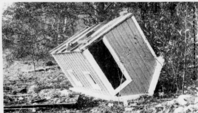
Spiderhytta til sjospeiderne på Snarøya ble revet av grunnmuren under stormen - i dag ligger den opp-ned i strandkanten. (Foto: Karl Braanaas)
