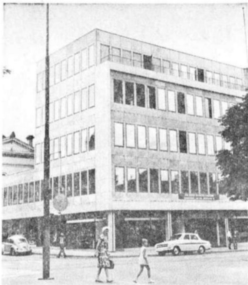
Drammens Sparebanks nybygg på Bragernes Torv.
