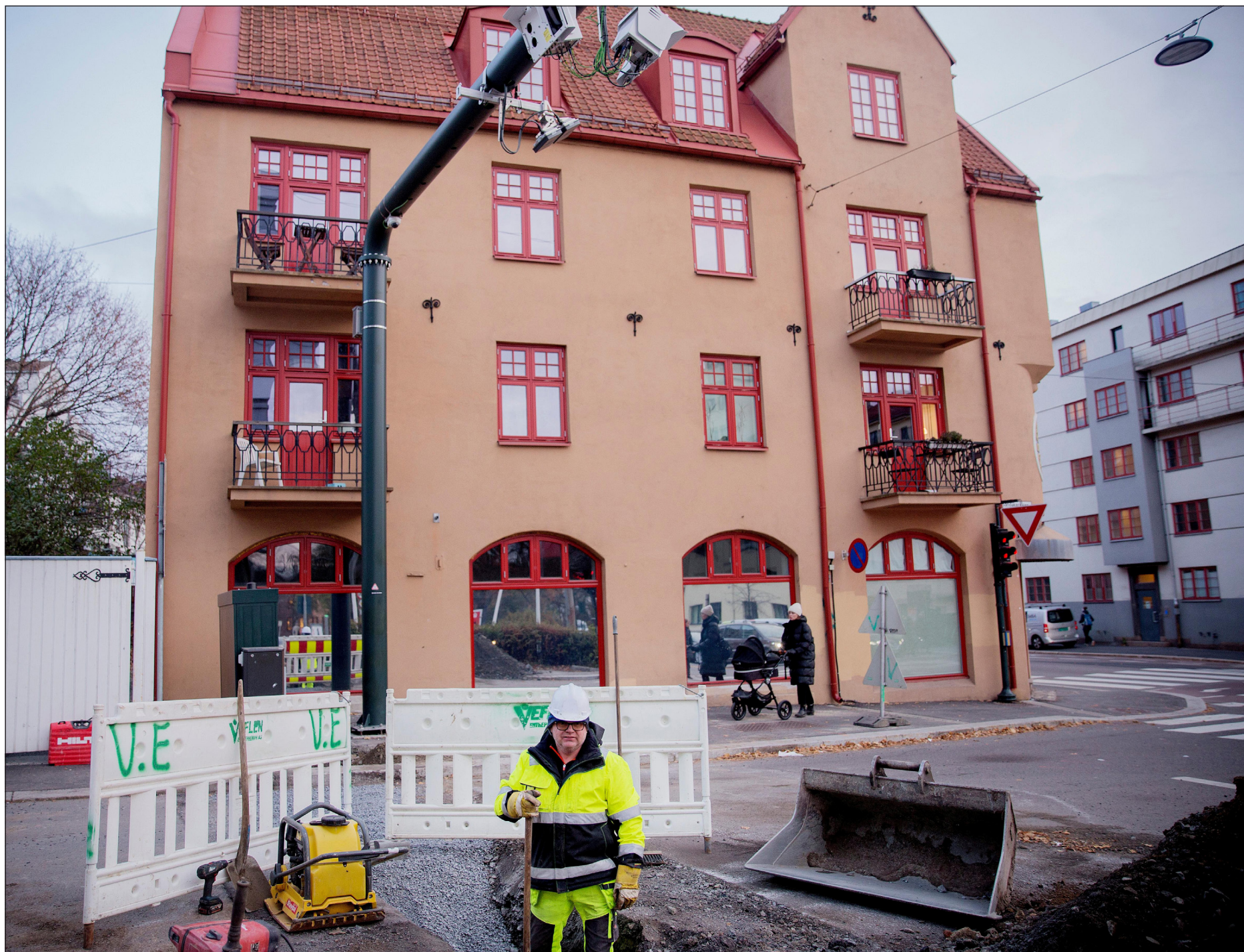
Knut Ragnhildsløkken i Mesta er i gang med gravearbeidet før selve bommen flyttes om et par ukers tid.
