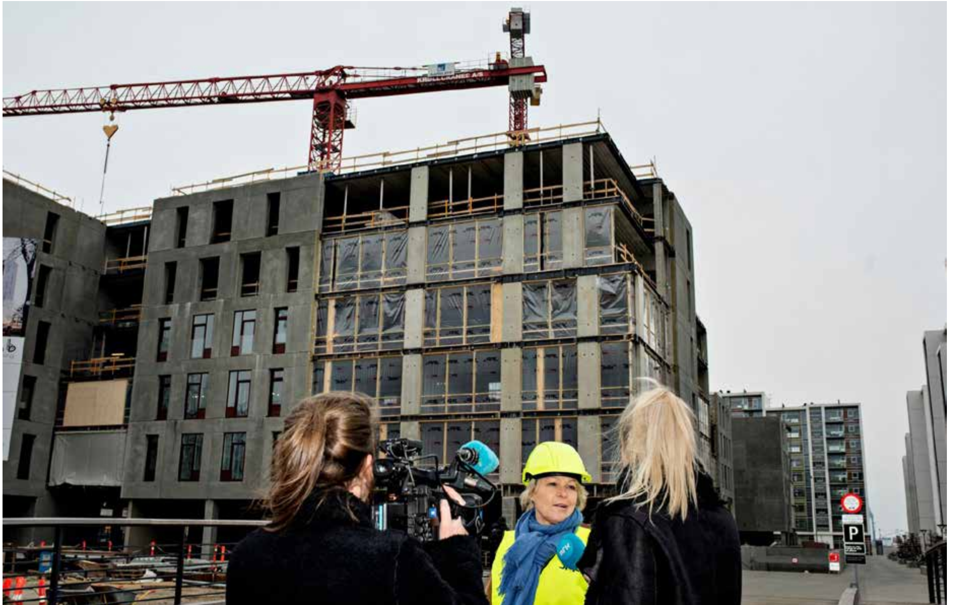
Eldre- og folkehelseminister Åse Michaelsen på byggeplassen i Århus hvor Generasjonernes hus er under oppføring. Foto: Maud Lervik
