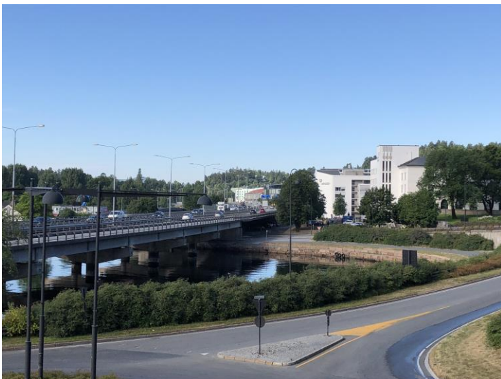
E18 går som viadukt over Sandviksbukta.
