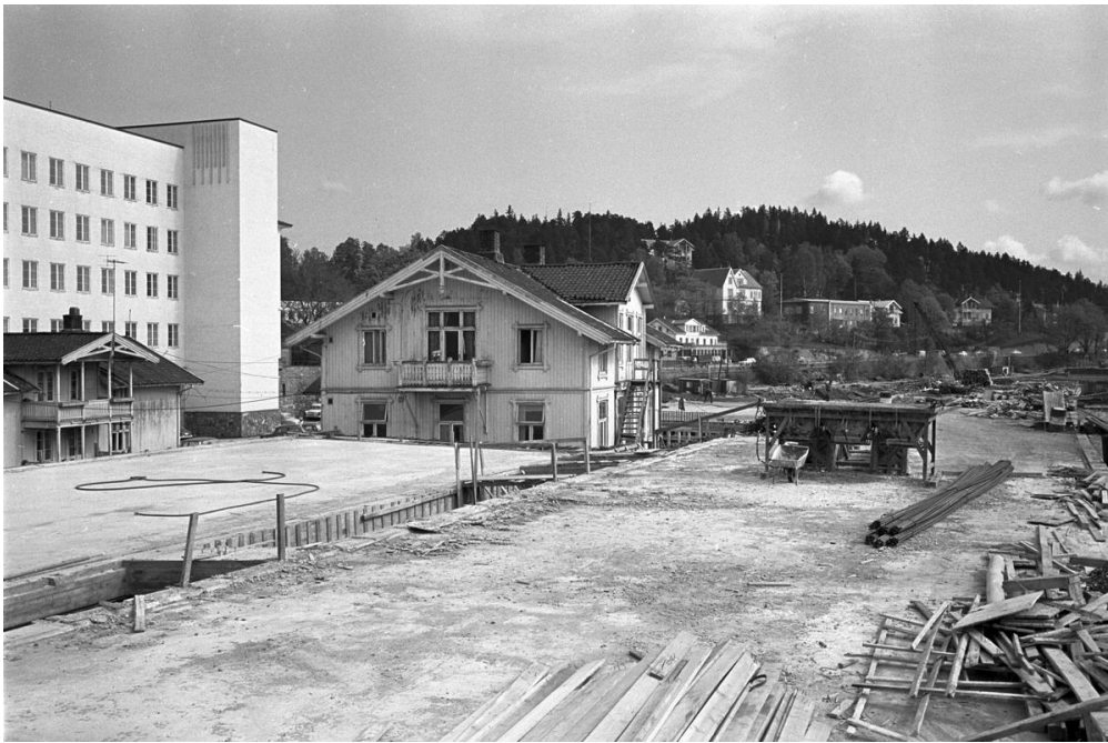
Bygging av ny E18 i 1960-årene
