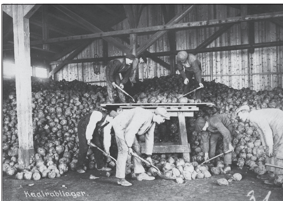
Provianteringsrådets kårabilager på Filipstad i 1919. Kjøttmangelen skapte stor etterspørsel etter mettende grønnsaker som kålrot, og både poteter og kålrot måtte rasjoneres.
